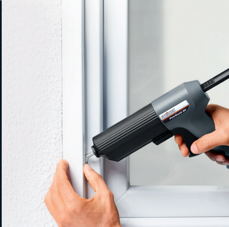
▼ Felerősítés Profil elhelyezése műanyag ablakokon.
